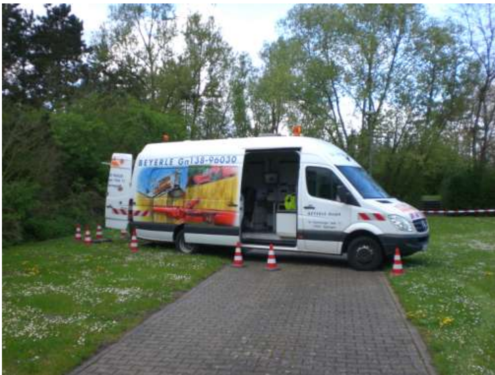
Demonstration einer Kamerabefahrung im Kanal
