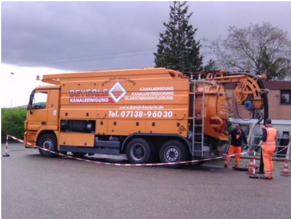
Interessante Einblicke in die Kanalreinigungstechnik
